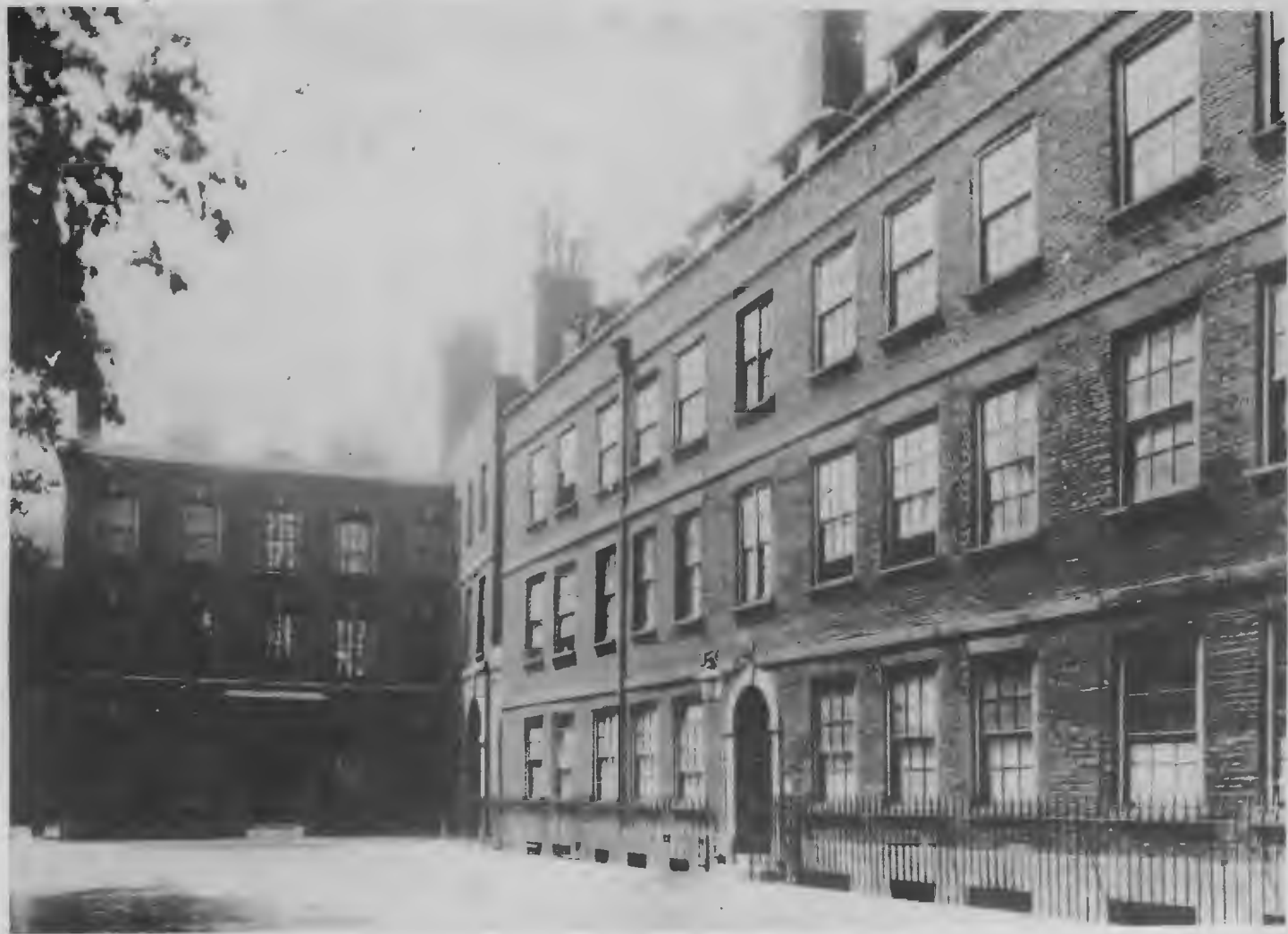
O New Inn, em Wych Street, demolido em 1905. (Foto cedida pelo London County Council).
