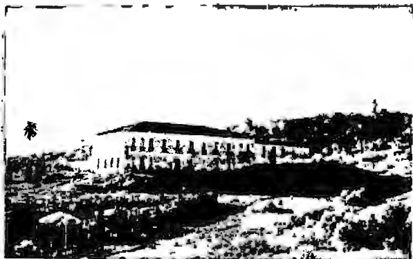
Sobrado do "Engenho Passagem", no Município da Cidade do Salvador.
