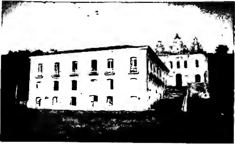
Capela e sobrado (fachada sul e fachada principal) do “Engenho Freguesia”, vendo-se bem a rampa, a escadaria e os caixotins, em via de reposição, que cobriam os cachorros sob as janelas em sacadas do andar nobre.
