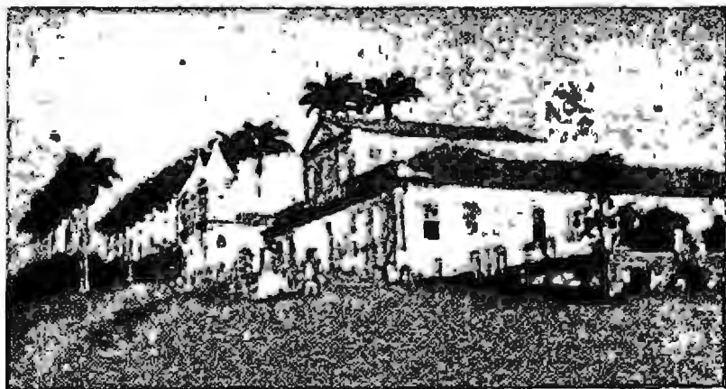
Sobrado e capela do “Engenho Paramirim”, no Município de São Francisco do Conde.
