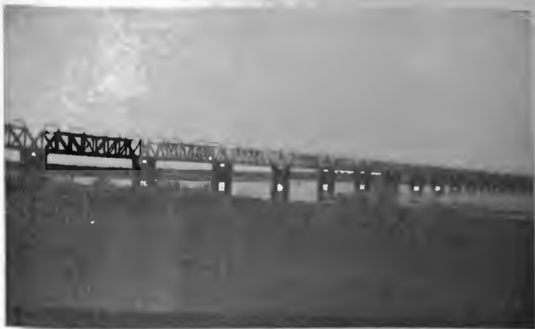
Na Barra do Quaraí (fronteira com o Uruguai — Rio Grande do Sul). Ponte internacional. (Agosto 1930)
