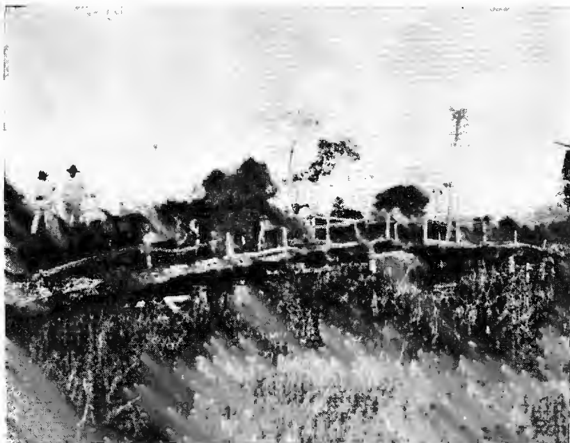
Atravessando uma ponte rústica em Mato Grosso. (Foto da Comissão Rondon).
