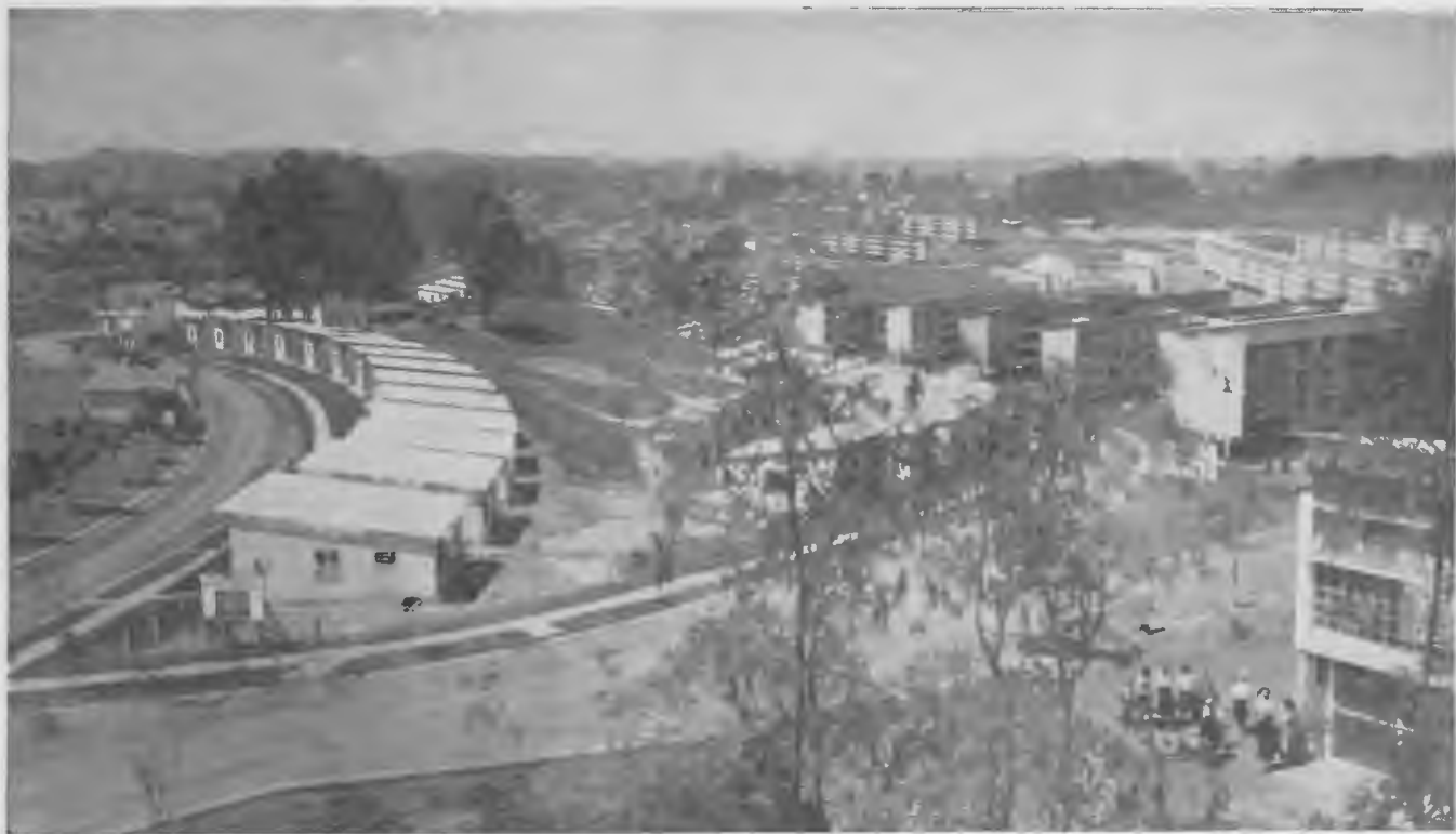
O conjunto residencial do I.A.P.I., em Santo André (Gentileza do "Câmara-Clube" da cidade).
