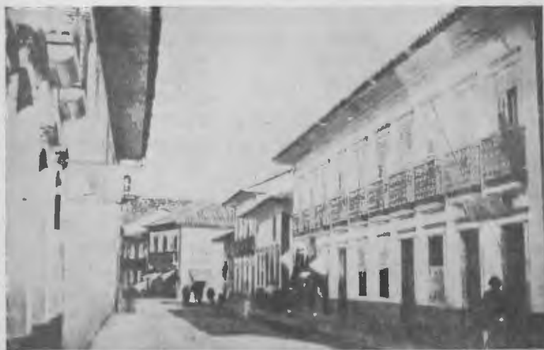
A Rua Direita na década de 1860-70. — Tranqüila e provinciana, a mais importante rua do velho Centro aparece no trecho próximo à atual Rua Quintino Bocaiúva, no rumo da Praça da Sé. Em destaque, vê-se um palacete residencial, em cujos baixos alojavam-se lojas varejistas e pequenas oficinas. — (Foto do Arquivo do Dep. de Cultura).
