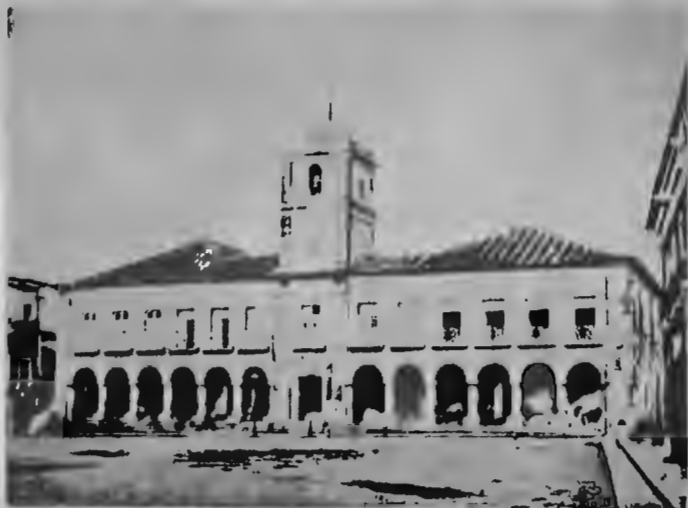
Senado da Câmara, cuja fachada foi remodelada em 1887 (Construção de 1660) — Ahi xistiu a antiga cadeia
