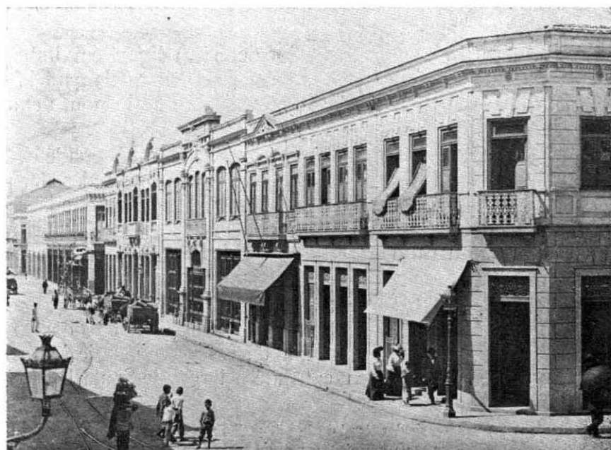
RUA DO ACRE (ANTIGA DA PRAINHA) AS NOVAS EDIFICAÇÕES DEPOIS DO ALARGAMENTO
