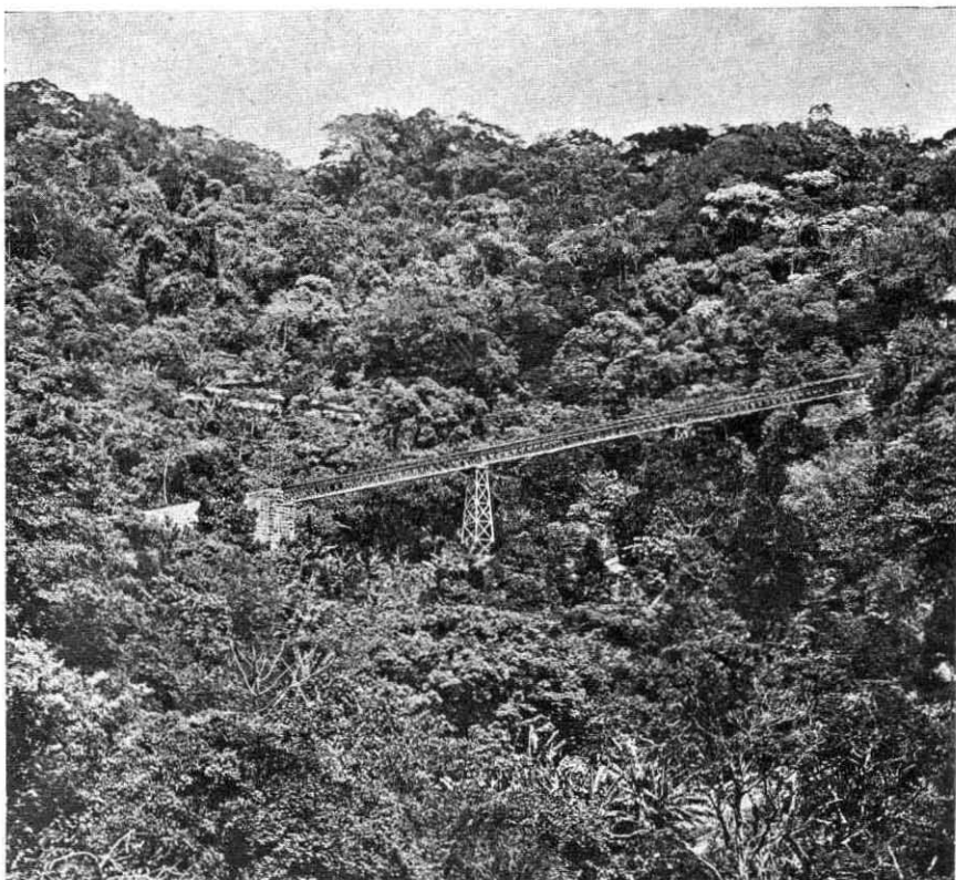
VIADUCTO DO SILVESTRE
