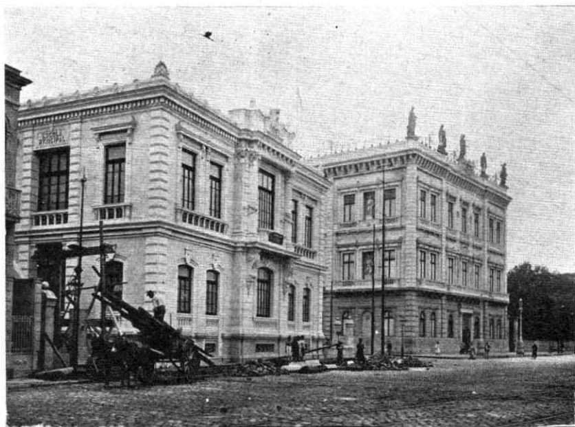
O MESMO TRECHO COM A ESCOLA "RODRIGUES ALVES" EM CONCLUSÃO
