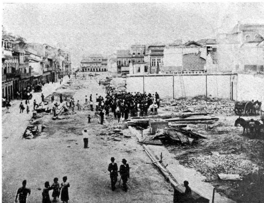
ALARGAMENTO DA RUA DO ACRE, VENDO-SE AINDA OS ALICERCES DAS CASAS DEMOLIDAS, E O NOVO ALINHAMENTO, A PHOTOGRAPHIA FOI TIRADA NA HORA DO LEILÃO DOS TERRENOS. 14-1-904.
