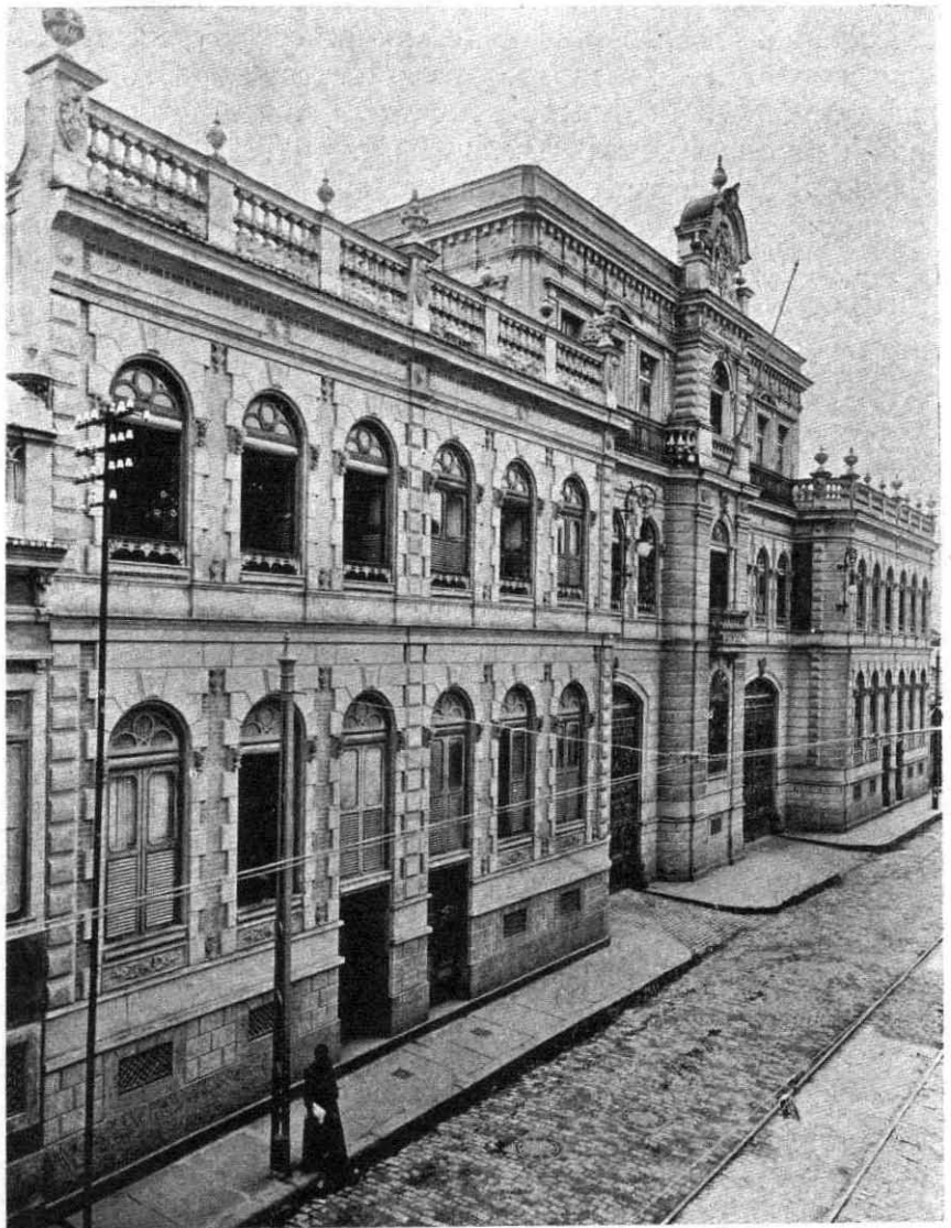
FACHADA POSTERIOR DO CORPO DE BOMBEIROS
